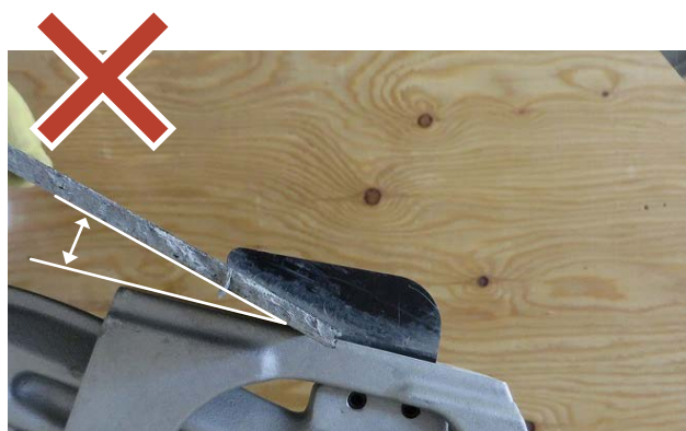
屋根材が浮いていると、クラックや割れの原因に。
