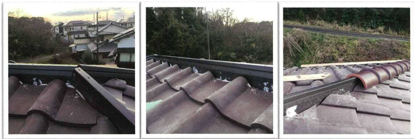
⑦ 楽棟は通りが良い為、金具工法における金具の高さ調整や棟垂木の振れ調整等が不要（工期短縮省施工）
