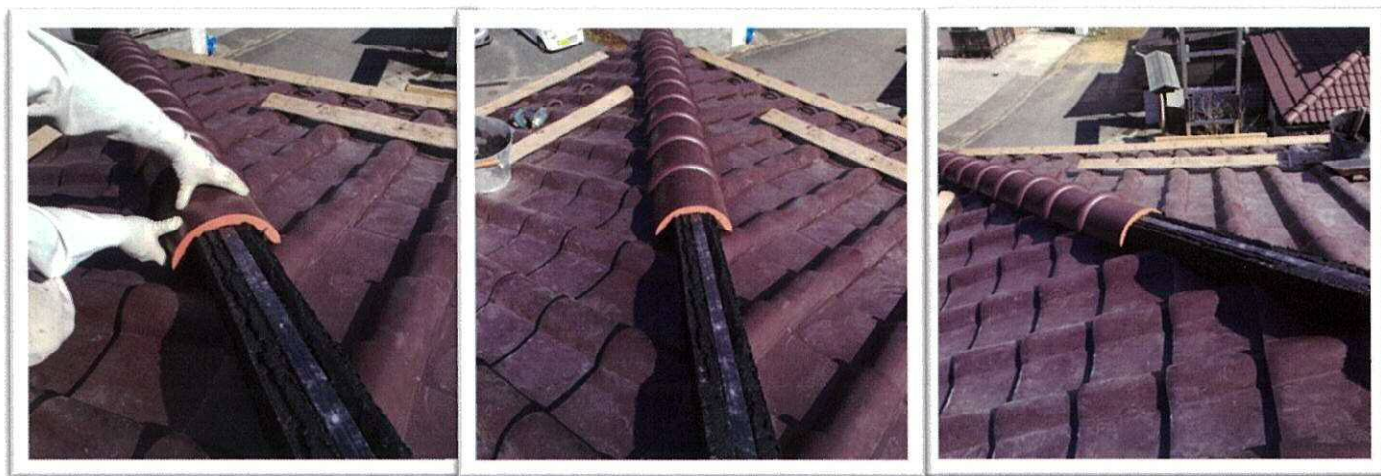
⑨ 隅棟部なんばん漆喰塗布後 棟瓦の通りを調整しながら楽棟ハットのうえに乗せつける。
