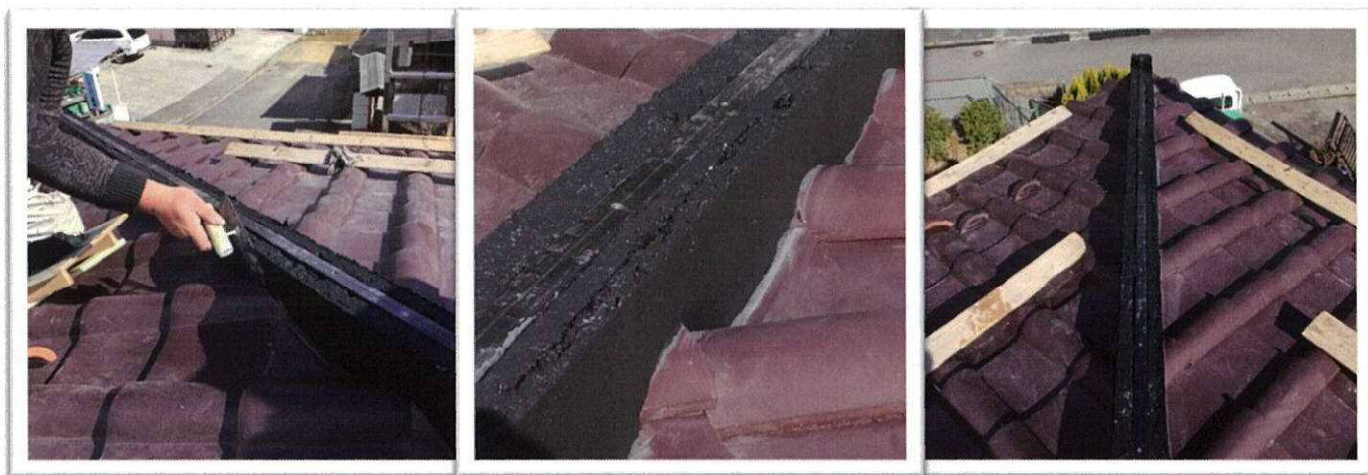
⑧ 棟部土台になんばん等を塗布する。 なんばん漆喰の使用量が30%程減る。（なんばん漆喰の削減）
