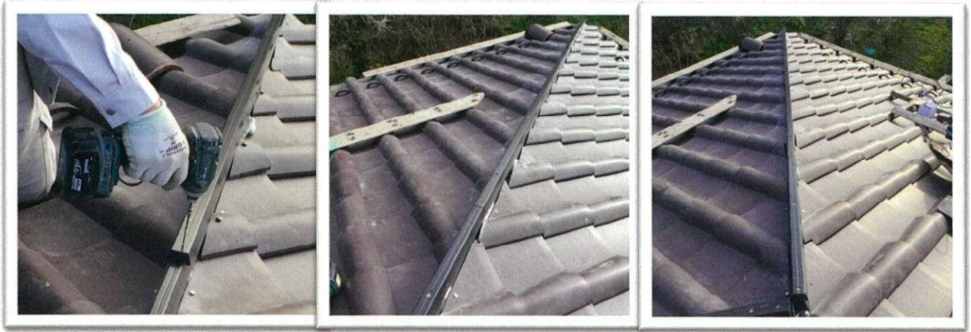
① S系瓦の為 楽棟ハット 30 の上に更に楽棟ハット 15 を乗せ仮止め固定する。
