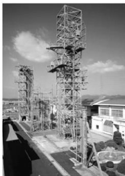
屋外試験鉄塔群
